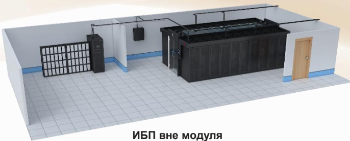
ИБП вне модуля (прецизионный ШРП)
